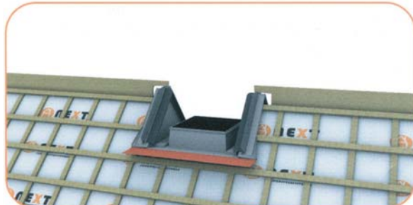
2. Plaats de bak op de onderconstructie, monteer de panlatten en pur de bak langs het dak af. Schroef de gootstukken vervolgens op de panlatten.
