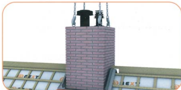
3. Hijs de gemetselde kolom, aan de hijsogen, in de bak. Vervang de hijsogen daarna door dopmoeren.
