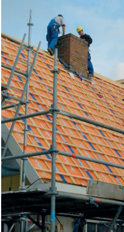
Een schoorsteen plaatsen kan met het Next systeem nu binnen 6 tot 8 manuren.
