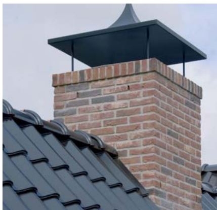
Het eindresultaat is een lekvrije schoorsteen die uit het dak lijkt te komen.
