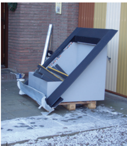
De kunststof bak waarin de nieuwe overzetschoorsteen komt te staan.
