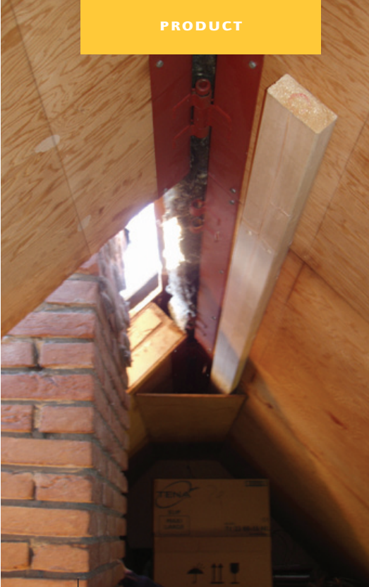
Een houten balk als nieuwe raveling vangt de dakelementen op.
