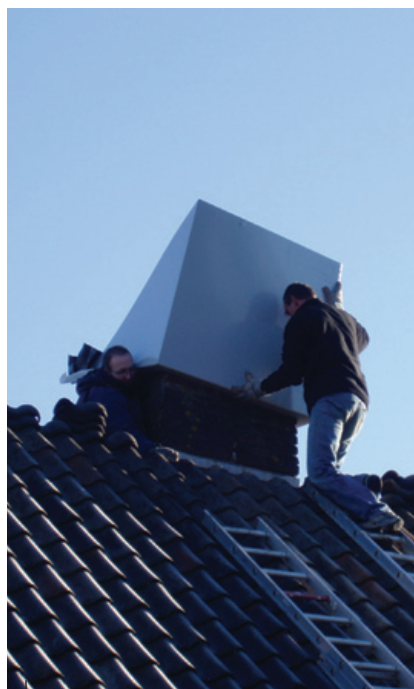
De kunststof bak wordt over de schoorsteen getild en in de vrijgemaakte ruimte geplaatst.
