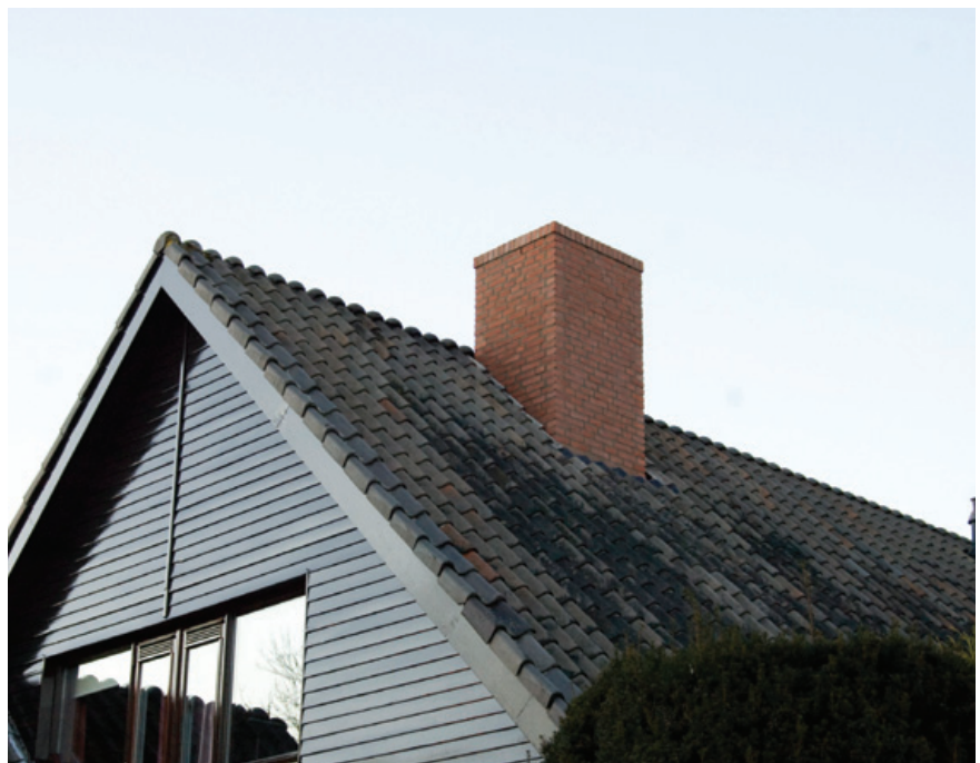
De overzetschoorsteen zakt langzaam over de bestaande heen tot in de sleuven van de kunststof bak.
