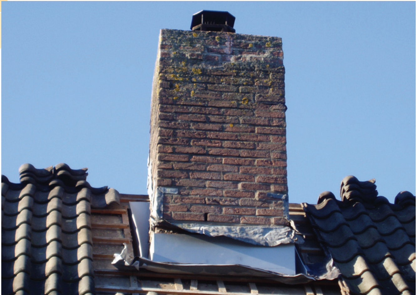
De bak komt nergens boven het dakbeschot uit.
