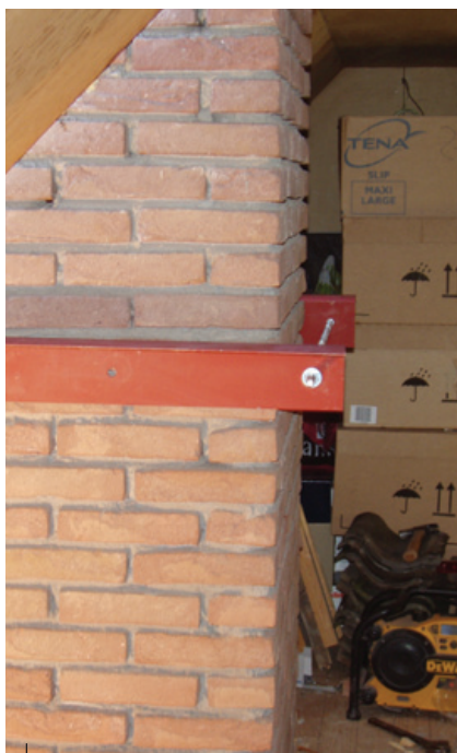
Twee hoeklijnen aan weerszijden van de schoorsteen dragen de kunststof bak.
