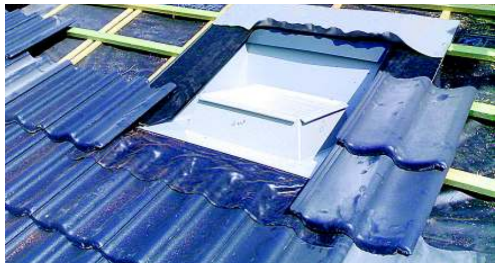
De lekbak van de Nextschoorsteen geeft water geen kans om binnen te dringen.
