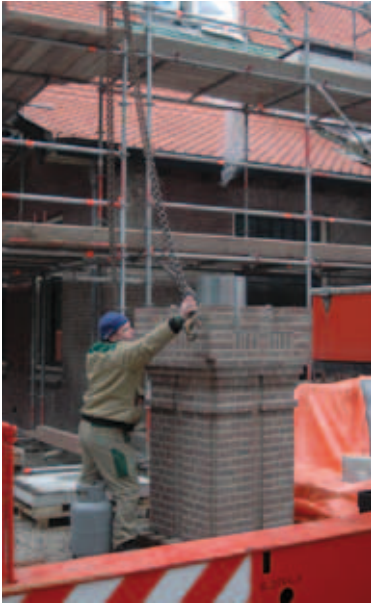
Een kraan hees de prefab schoorsteen aan de vier geïntegreerde hijsogen het dak op.
