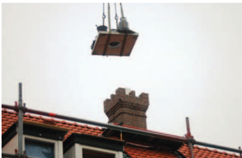
Een gewapende betonplaat met sparing werd als laatste op de gemetselde kantelen gestort.
