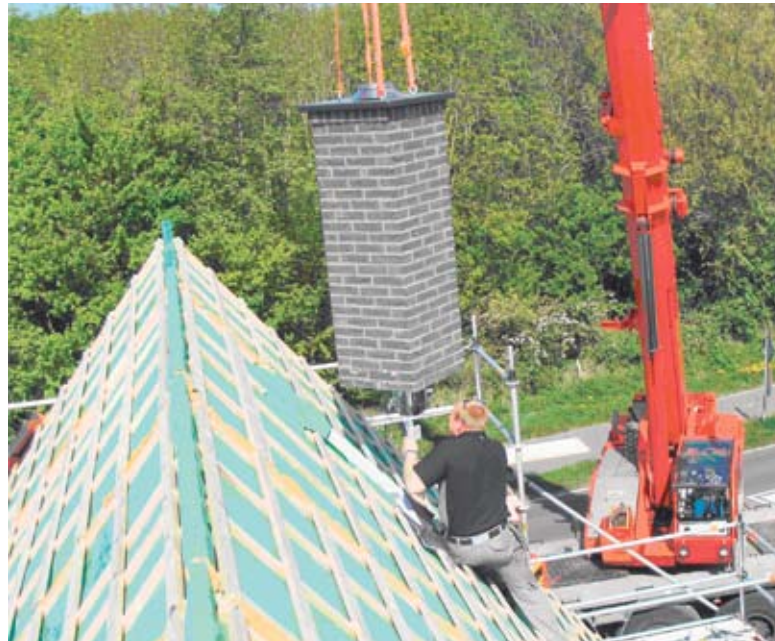
Plaatsing van een Next Schoorsteensysteem op Texel.
